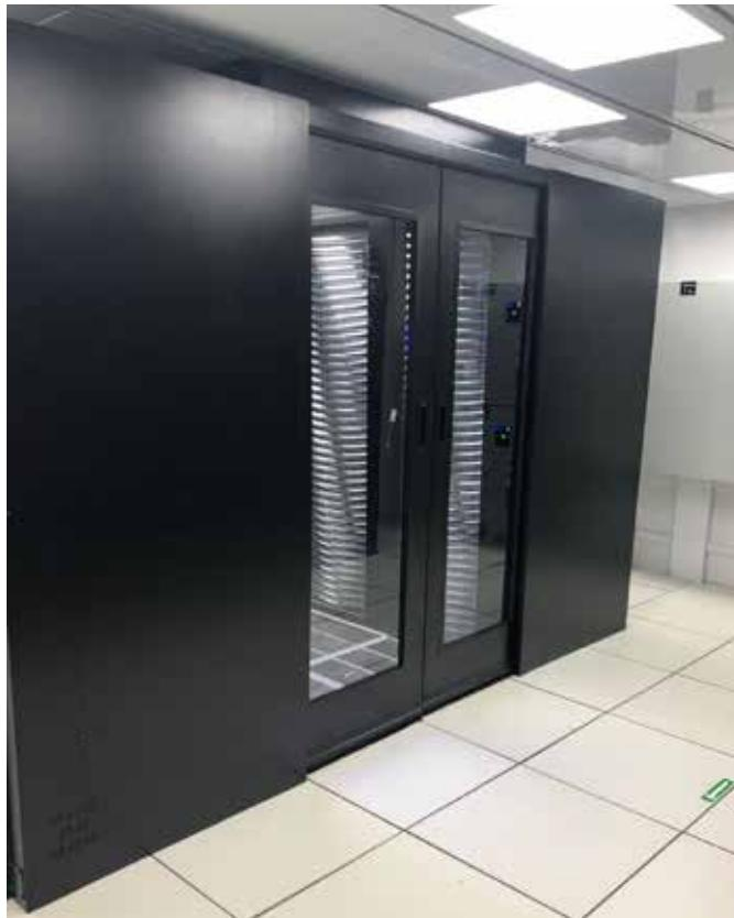
As paredes do DCM são fabricadas com chapa de aço 1.020 mm com tratamento galvanizado e pintura eletrostática poliéster com 75 micrôn na face externa. A face interna é
